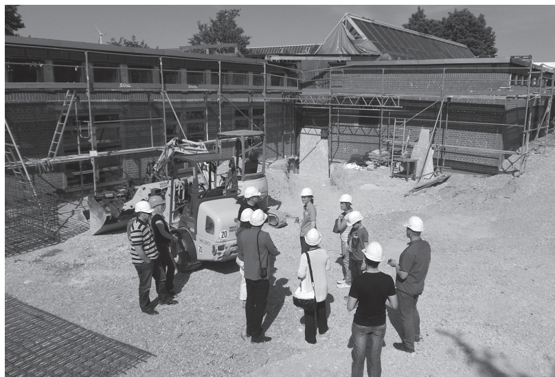
6.6.2014 – 87 Tage Baustelle Freizeitreff Freimann – ein Blick hinter die Kulissen.
